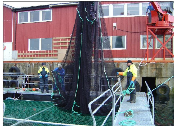
Bilde 56: Gamle stålanlegg fra lakse- og torskoppdretningsnæringen er populære for ombygging til mottaksmerder. En stabil ramme i aluminium danner grunnlaget for trampoline og bunnen av merden. Størrelsene varierer fra 5x5 meter til 20x20 meter.
